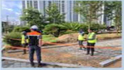
조경작업 근로자 안전모 착용하고 작업 하도록 주의 당부 바랍니다.(현장소장님 지시사항)
