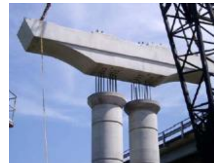
교량 하부 교각 PC
