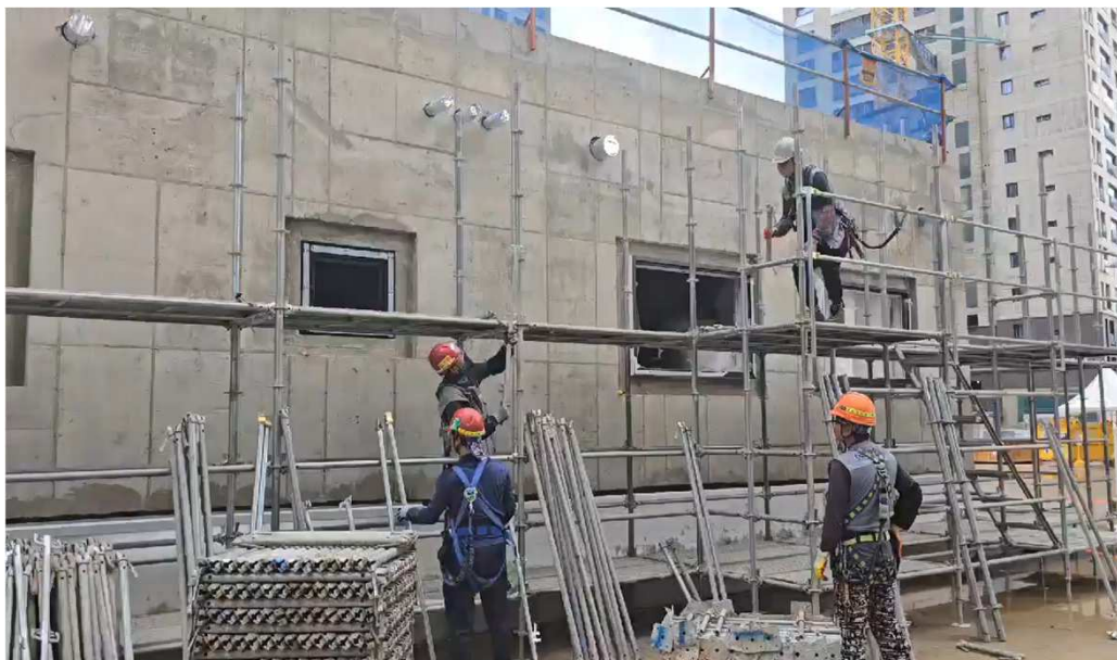
[선행 안전난간대 설치 동영상]
