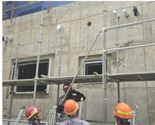
[2단계 선행 안전난간대 (2분) 체결]
