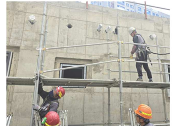
[3단계 선행 안전난간대 (2분) 후 수직재 설치]
