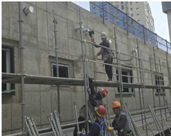
[1단계 수직보조재 설치]
